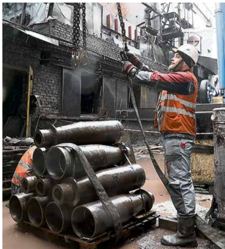
Опыт, накопленный ремонтниками комбината, позволяет им параллельно вести капремонт и реконструкцию
