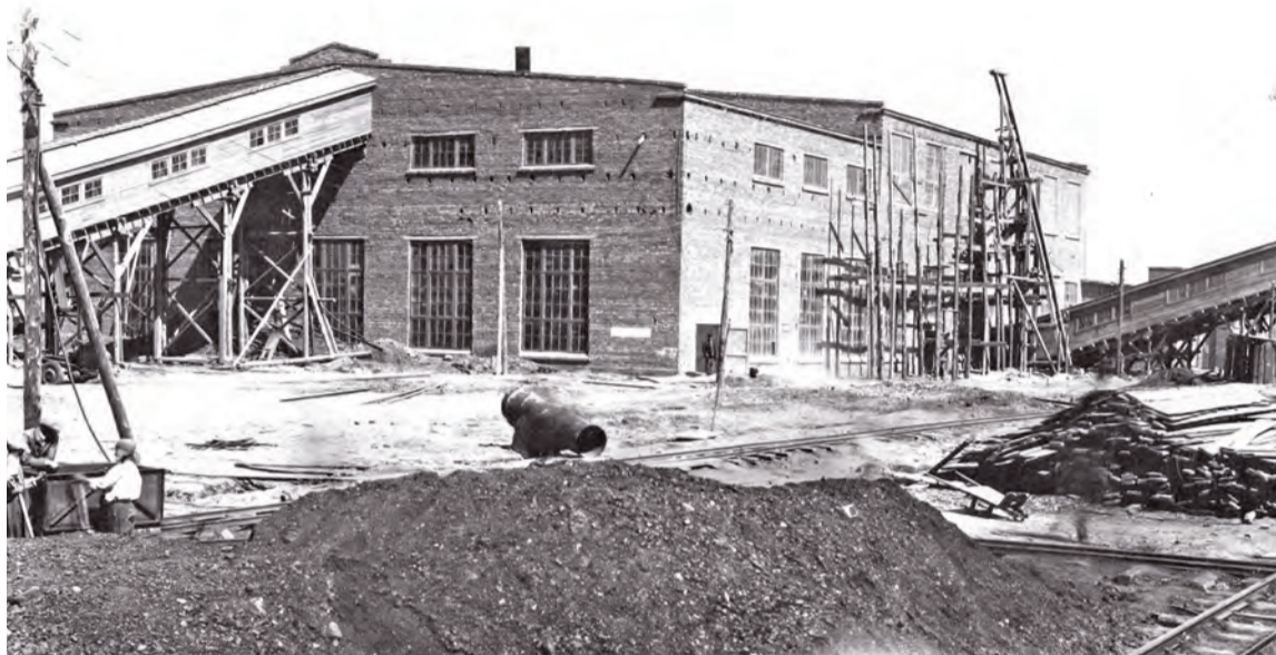
▲ Огнеупорный (шамотный) цех. Дефицит стройматериалов постоянно даёт о себе знать: опоры конвейерных галерей и их крытые части выполнены из отёсанной сосны
