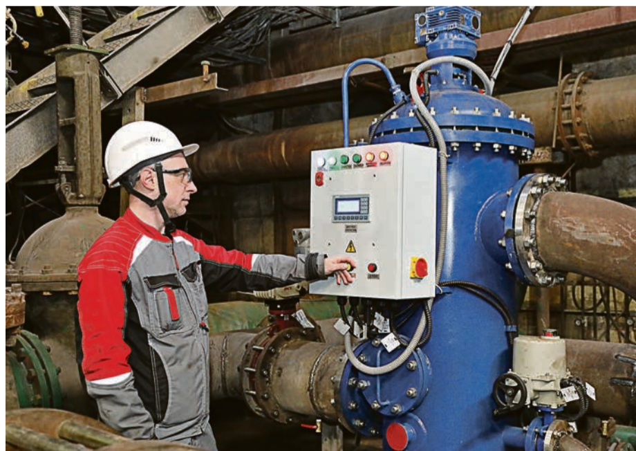
▲ На новых фильтрах предусмотрена индикация параметров работы световой сигнализацией. Для коррекции режимов работы используют ЖК-дисплей блока управления
