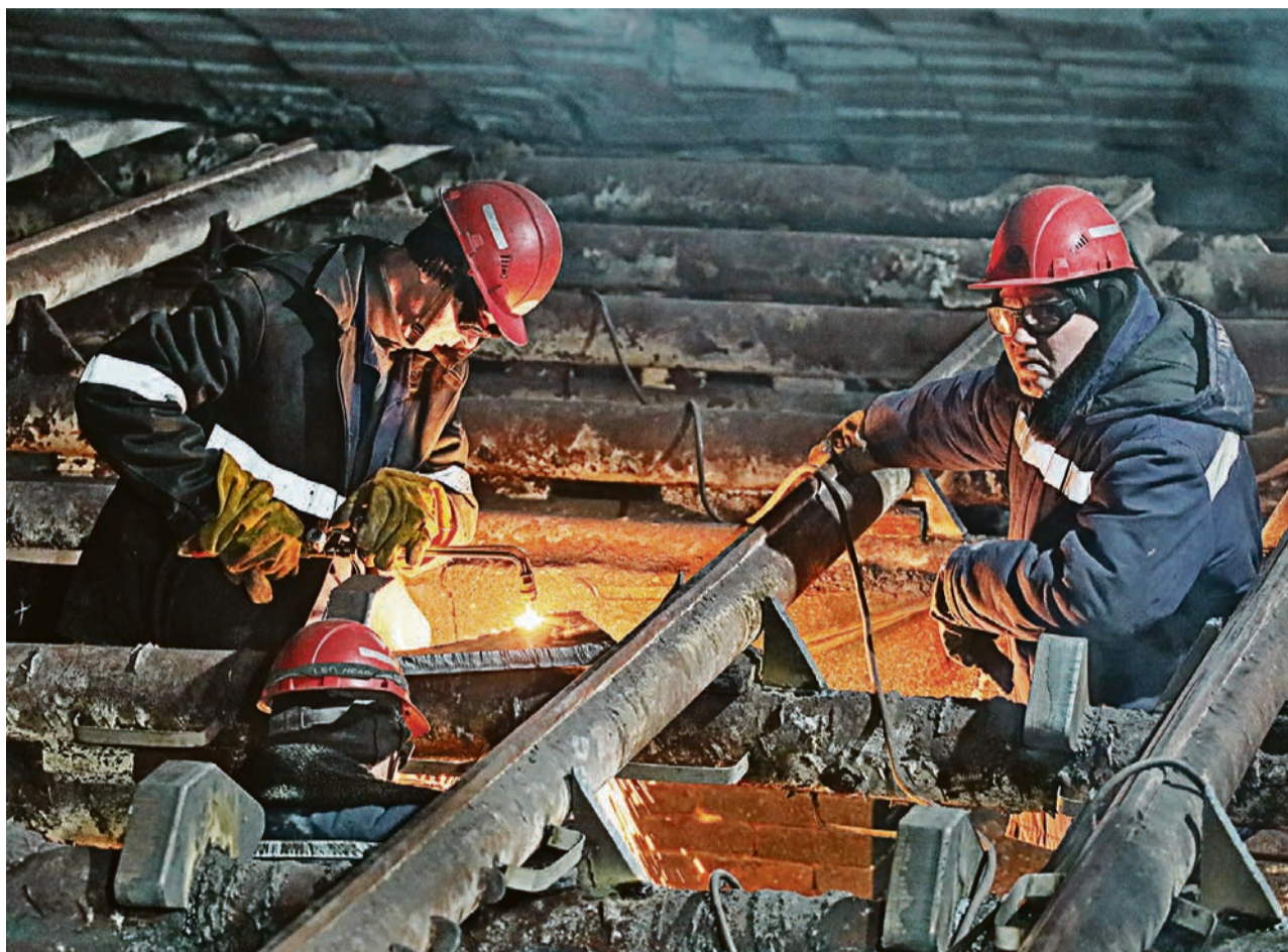
▲ По окончании ремонта глиссажные трубы укроют огнеупорным бетоном, чтобы два следующих года они уверенно держали на себе слитки внутри бушующего моря огня
