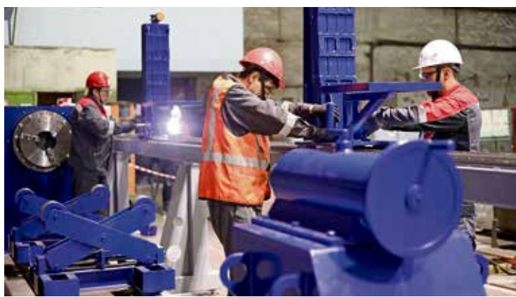
◀ Наплавочная установка, поступившая в станочный парк механического цеха, повысит операционную эффективность Уральской Стали за счёт восстановления запчастей своими силами
