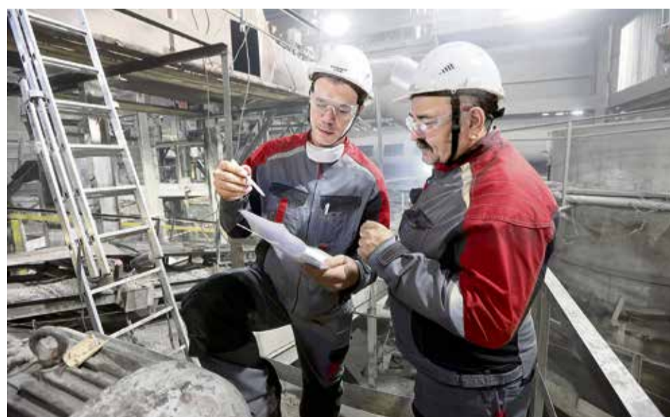
▲ Чтобы работы были закончены в срок, инженеры-ремонтники постоянно контролировали ход работ на подшефной площадке
