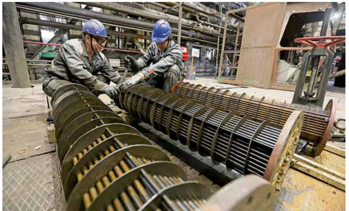
▲ Через руки опытных ремонтников одна за другой проходят секции теплообменников: их ждут очистка, проверка герметичности и установка на штатные места
