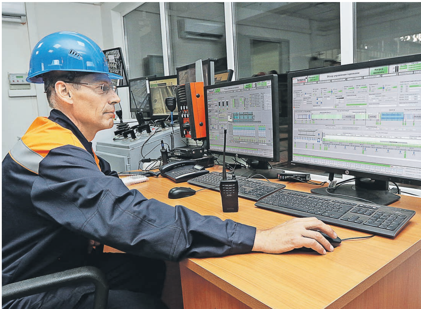
В операторной: электронная начинка современной термозаклочной печи – надежный помощник прокатчикам Уральской Стали
