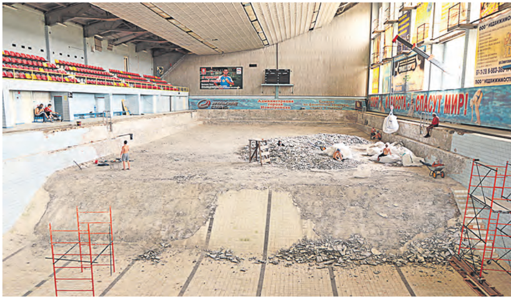
Сегодня главный фронт для строителей – пятидесятиметровая ванна бассейна
