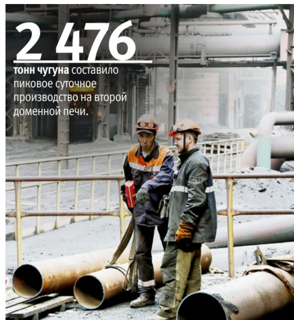
▲ Вместо газопровода диаметром 159 миллиметров специалисты проложили магистраль диаметром 219 миллиметров, позволяющую подавать в печь больше топлива
