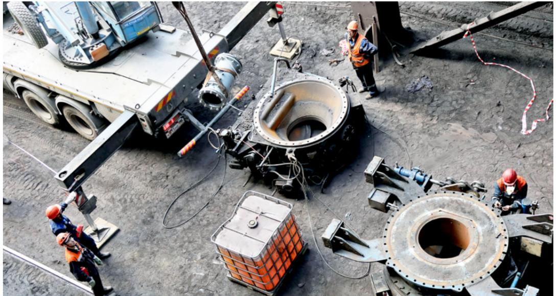
▲ В первый день ремонта слесари ЦРМО соединили две части верхнего комбинированного клапана и установили его на предназначенное место
