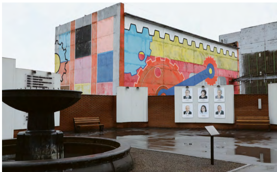
◀ Тематику росписи электрической подстанции — конструктивистские шестерни и зубчатые рейки — авторам подсказала близость механического цеха
