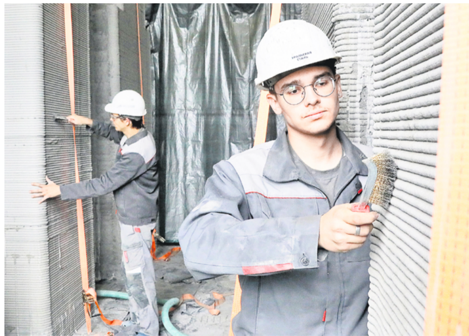
◀ Строители из «РОКЕТ-групп» сегодня заняты финальной очисткой готовых монолитных панелей от мелких поверхностных дефектов
