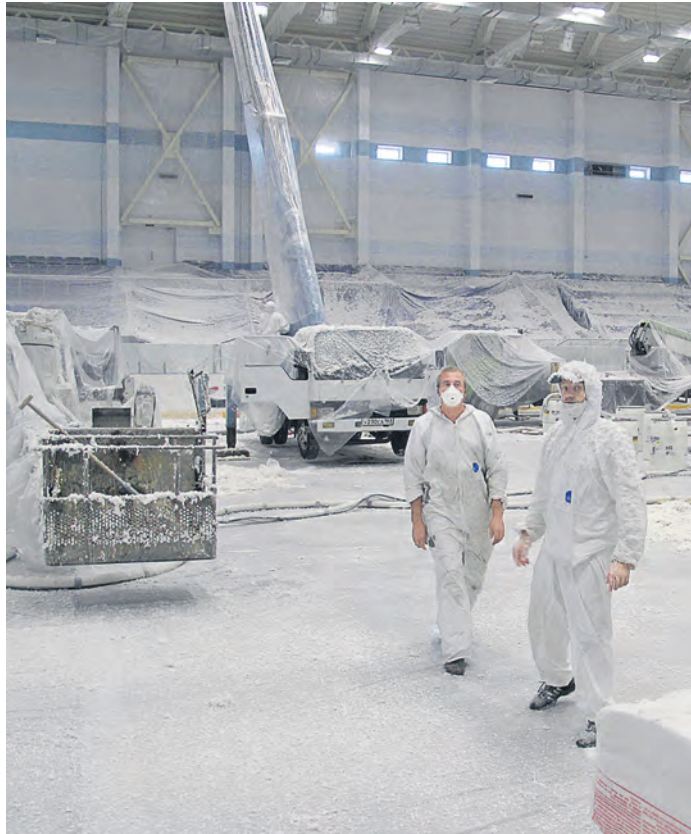
Резонирующие конструкции «Победы» обработаны звукопоглотителем
