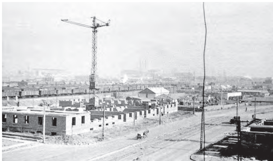
Строительство дома на улице Советской, начало 50-х годов
