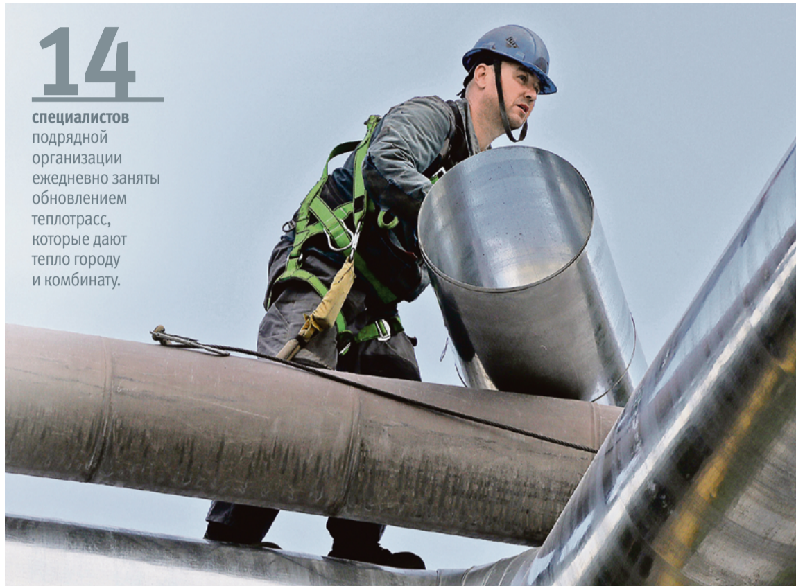
▲ Последний штрих ремонта — установка оцинкованных жестяных листов, которые защищают мягкую теплоизоляцию от дождей и ветров
