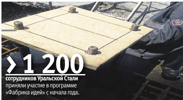
▲ Фанерные шаблоны позволяют строителям быть уверенными: каждый элемент конструкции сядет на своё место без допусков и погрешностей
