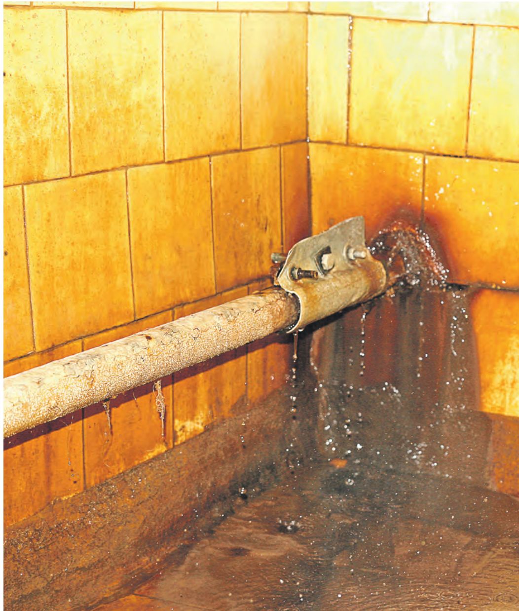
Креативный подход: вместо сварки самодельный хомут – дешево и сердито
