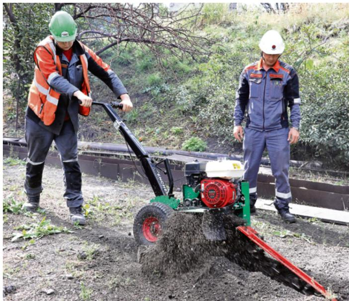
▲ 100-миллиметровая ширина реза нового агрегата оптимальна для укладки как силовых, так и сигнальных кабелей железнодорожников
