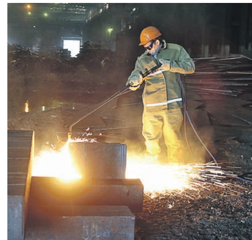
На огонь можно смотреть часами, но газорезчику на работу отведены считанные минуты
