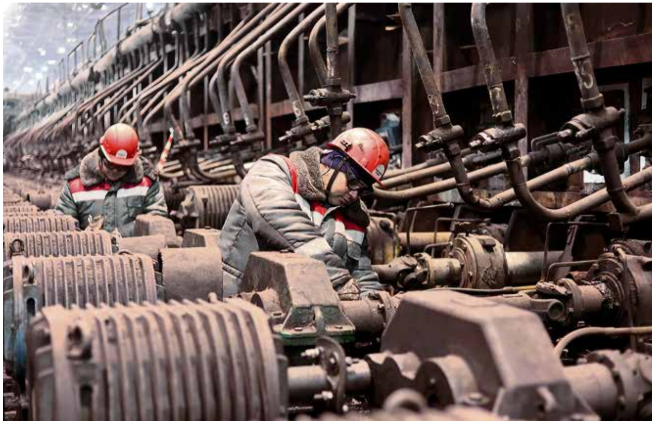
▲ Ремонтные бригады поочередно восстановили электрическую, механическую, энергетическую и огнеупорную составляющие закалочной машины, и сегодня она уже включена в общий технологический поток
