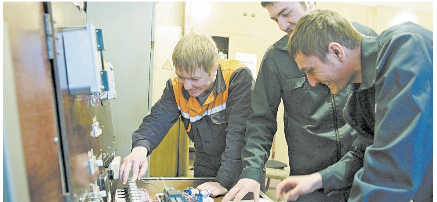
Заявленный экономический эффект будет достигнут. В этом у инженеров сомнений нет
